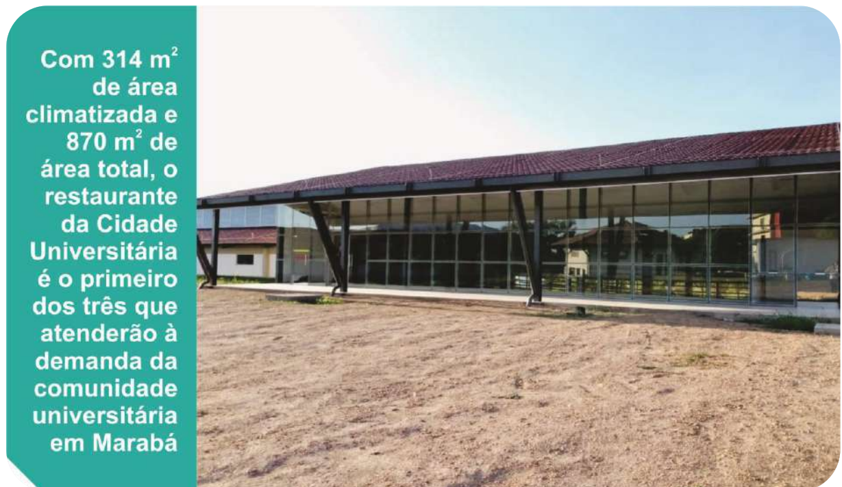
Figura 14 – Vista externa do prédio que abrigará o 1º restaurante universitário no campus Marabá
